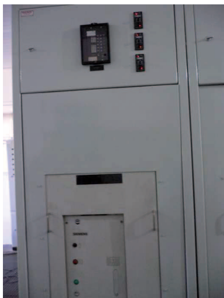
Foto 3 – Painel de Partida do Motor (Externo)
