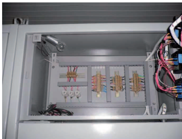
Foto 4 – Painel de Partida do Motor (Interno)
